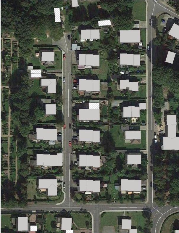
Abbildung 32: 3-Parteien-Reihenhäuser im Fokusgebiet Dichterviertel (Quelle: OCF)
