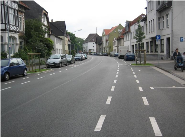
Bild 7: Beidseitige Schutzstreifen mit Sicherheitstrennstreifen zu parkenden Kfz (Lemgo)
