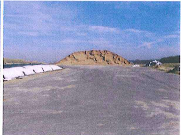
Abb. 7 Siloplatte im Osten des Vorhabengebietes vorhanden (P. Scharlibbe Oktober 2010)
