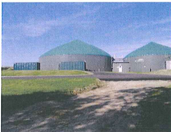
Abb. 4 Blick von der Meezener Straße (K 50) aus auf die in Betrieb befindliche Biogasanlage mit Nachgärer und Güllecontainer (P. Scharlibbe Oktober 2010)
