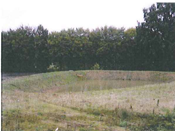
Abb. 8 Regenrückhaltebecken im westlichen Bereich des Betriebsgrundstücks von Norden (P. Scharlibbe September 2010)
