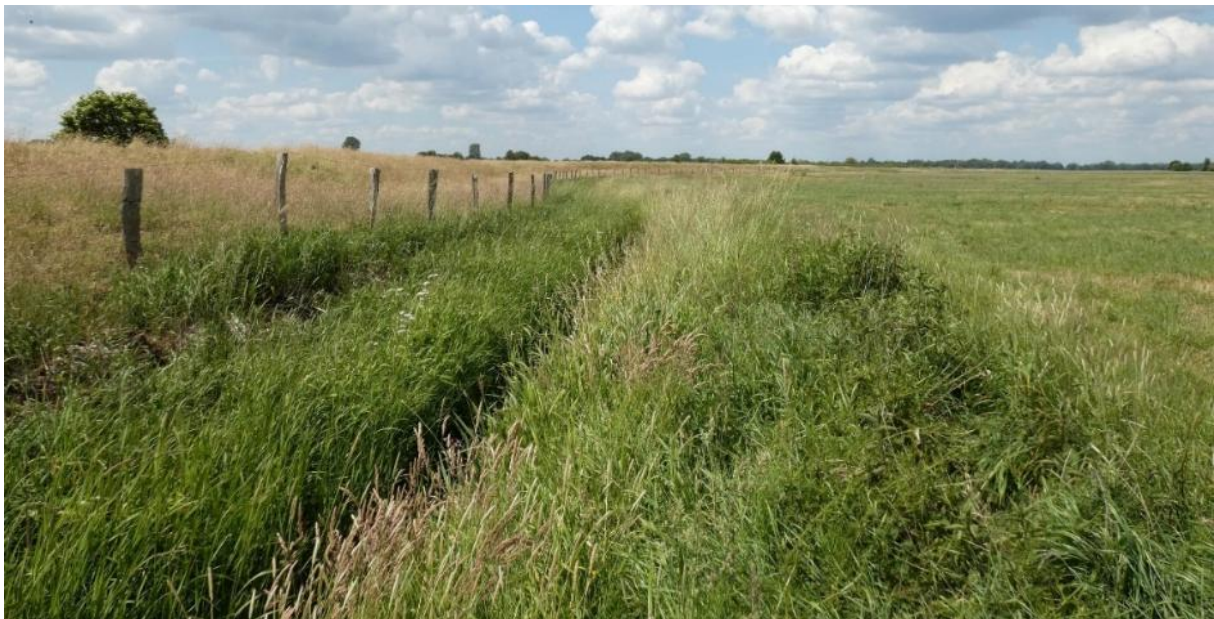
Abbildung 16: Sicht entlang der nördlichen Seite der Deichstruktur (XD s ) (links im Bild) vor dem südlich gelegenen Kätners Graben (Fly). Blickwinkel von Osten her nach Westen (Bild: Elbberg 2023).
