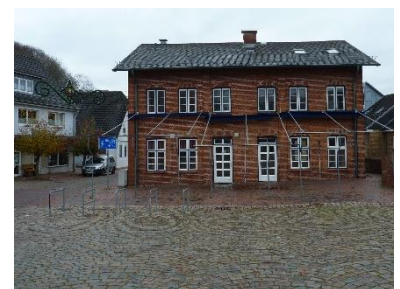
Abb. 143: Leerstand, der wieder beseitigt ist: Wie vor seiner Schließung dient das den Oberen Markt prägende Gebäude Hauptstr. 24 seit dem Dezember 2019 wieder als griechisches Restaurant
