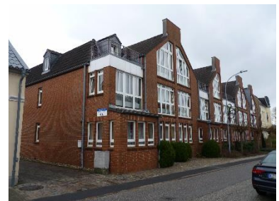
Abb. 148: Pflegewohnanlage Am Rosengarten , Ansicht aus der Hauptstraße
