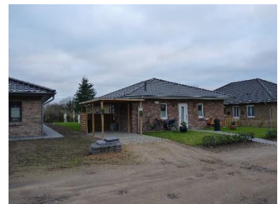
Abb. 99: Kein Sanierungsbedarf (Laurinatskoppel)
