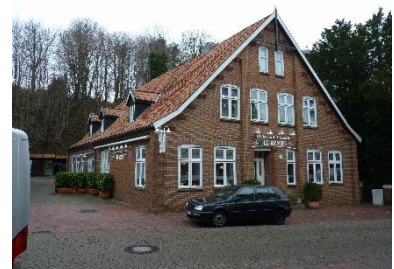
Abb. 100: Geringer Sanierungsbedarf (Hauptstraße)
