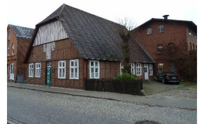
Abb. 26: Hauptgebäude der Lederfabrik Kobel in der Hauptstr. 42
