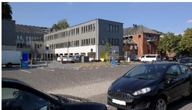
Abb. 80: Das Amtshaus vom Unterem Markt gesehen. Im Hintergrund das Gebäude Hauptstr. 16
