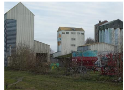
Abb. 227: Gewerbebauten südlich der Straße An der Stör ( Reimer Landhandel )
