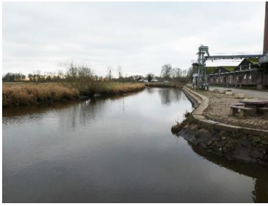
Abb. 27: Die Hafenanlage an der Stör mit dem Silo des HaGe Landhandel
