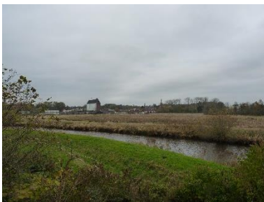
Abb. 35: HWS-Anlagen an der Stör, südlich des Untersuchungsgebiets
