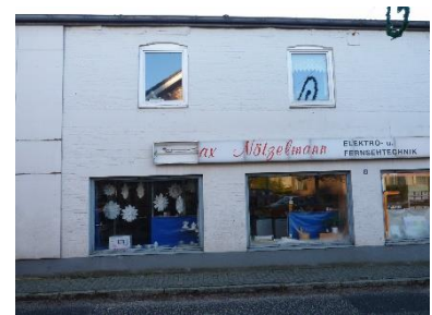
Abb. 228: gestalterische Defizite und Substanzschwächen: Gewerbebläche in der unteren Lehmburgstraße
