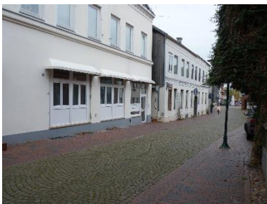
Abb. 225: verfestigter Leerstand in der Hauptstraße
