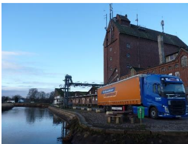
Abb. 145: Anlage der HaGe von der Hafensstraße gesehen
