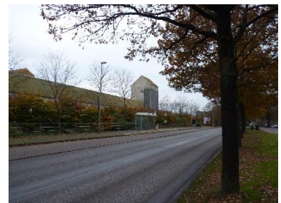
Abb. 72: zentraler Bereich der Straße An der Stör, Blick von Nordosten
