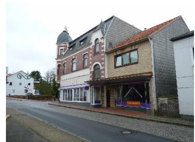
Abb. 90: Wohn- und Geschäftsgebäude (Lehbergstraße)
