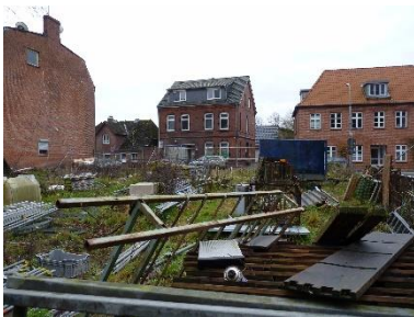
Abb. 226: die verfallenen Grundstücke in der Hauptstraße 39 / 41
