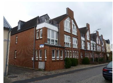
Abb. 83: Pflegeeinrichtung Am Rosengarten in der östlichen Hauptstraße.
