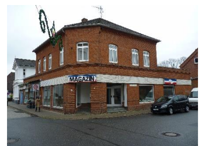
Abb. 172: verfestigter Leerstand in der Hauptstraße 38
