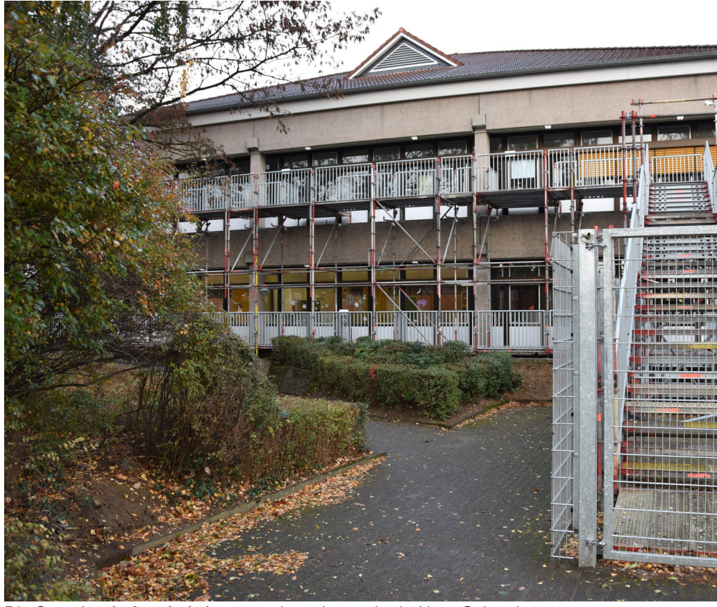
Die Gemeinschaftsschule heute – ein sanierungsbedürftiges Gebäude.
