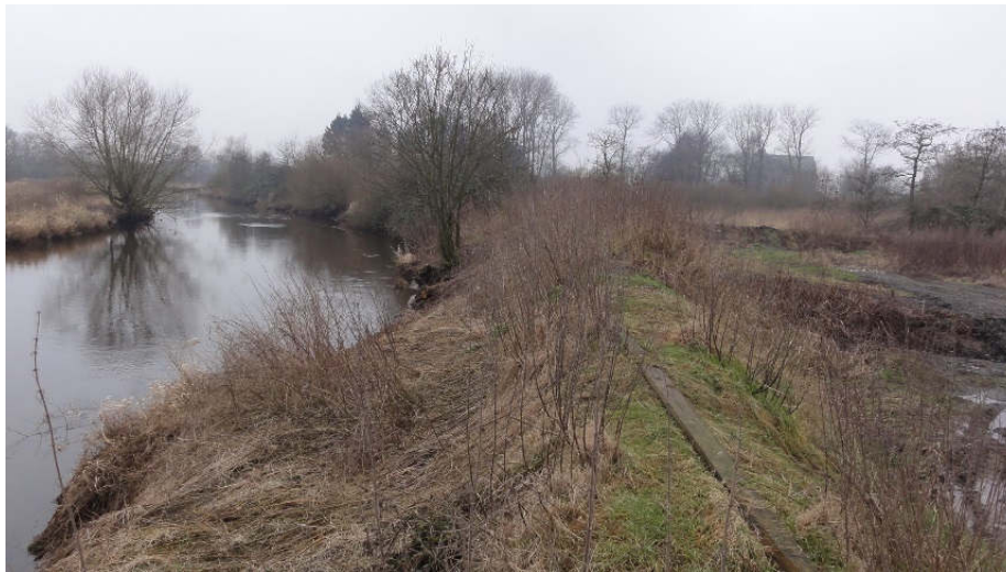
Abbildung 4: Stördeich Kellinghusen, rechts (Blickrichtung: unterwasserseitig Firmengelände Reimer)
