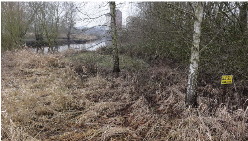
Abbildung 12: Bereich der Deichlinie zwischen Poggenwiese und der Koss & Eggers GmbH
