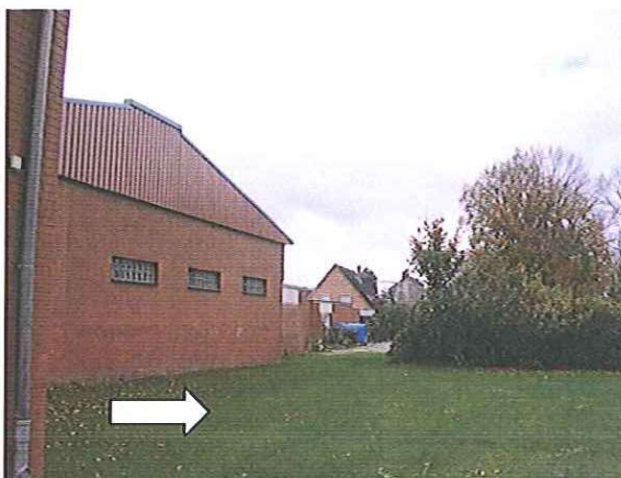
Abb. 14 rückwärtige Flächen hinter dem Feuerwehrgerätehaus, die für einen 2. Bauabschnitt weiterhin frei gehalten werden
