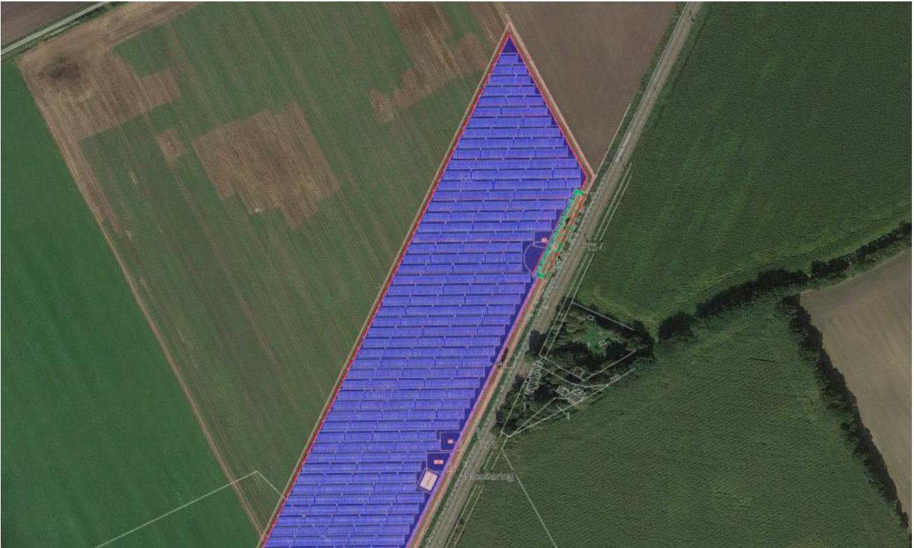
Bild 2.1.2: Detailansicht der PV Fläche (Quelle: Google Earth/SolPEG)
