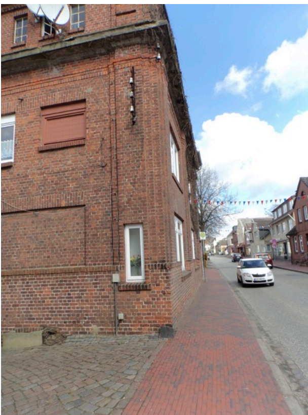
Foto 9: Ostseite Gebäude, Blick nach Norden.
