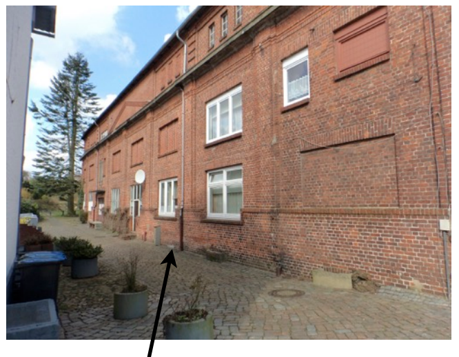
Foto 10: Kanalschacht für Abwasser nach 1964
