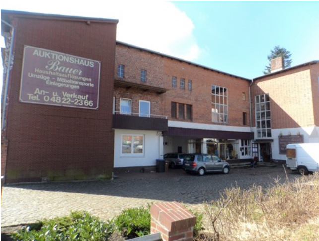
Foto 1: Nord-Ansicht Gebäudebestand, linker Teil Wohnhaus, rechter Teil Gewerbenutzung.
