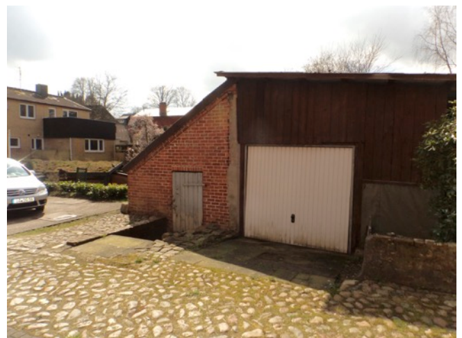
Foto 6: Schuppen südlich des Gebäudes
