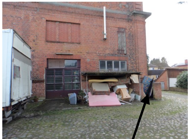
Foto 4: Blick nach Osten auf die Westwand des Gebäudes mit ehem. Lager für PER-haltige Abfälle der Reinigung
