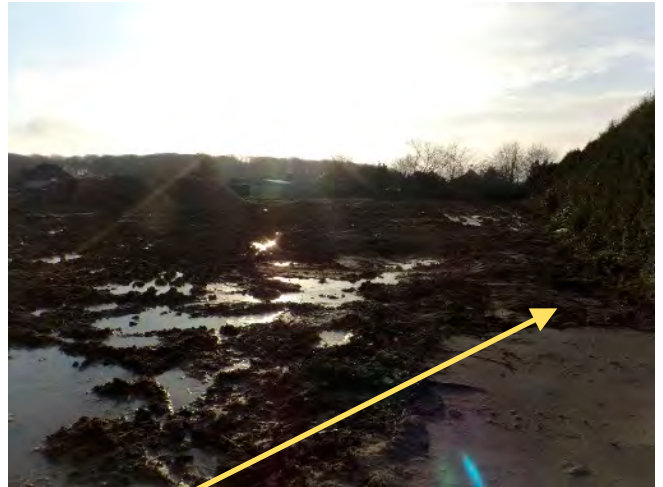
Foto 2: Blick nach Süden auf den Bereich des ehem. HEL-Tanks.
