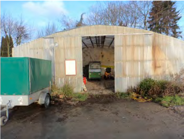
Foto 1: Leichtbauhalle im Nordwesten, Gerätelager, Boden mit Betonsteinen versiegelt, unauffällig.
