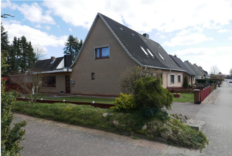
O.Grell. 10.04.19. Wohnhäuser, Plangebiet
