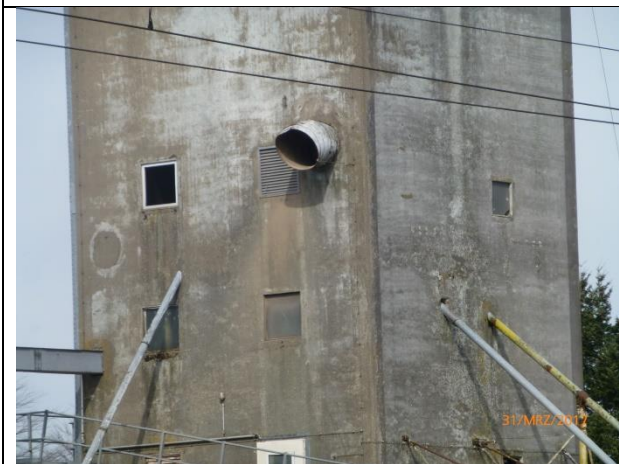
Bild 3: Alter Siloturm mit der Auslassöffnung Trocknung/Reinigung
