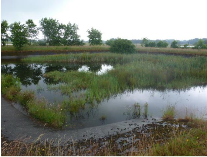
Foto O.Grell, 14.06.16. RRB der Firma VIN
