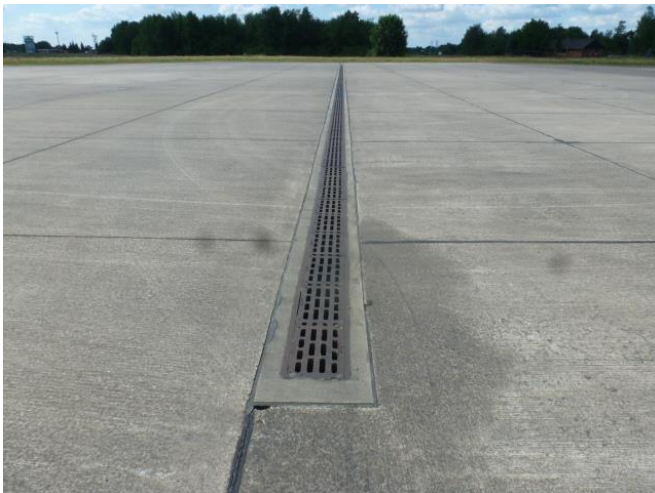
Foto O.Grell.09.06.16, Verrohrung des Bachlaufs
